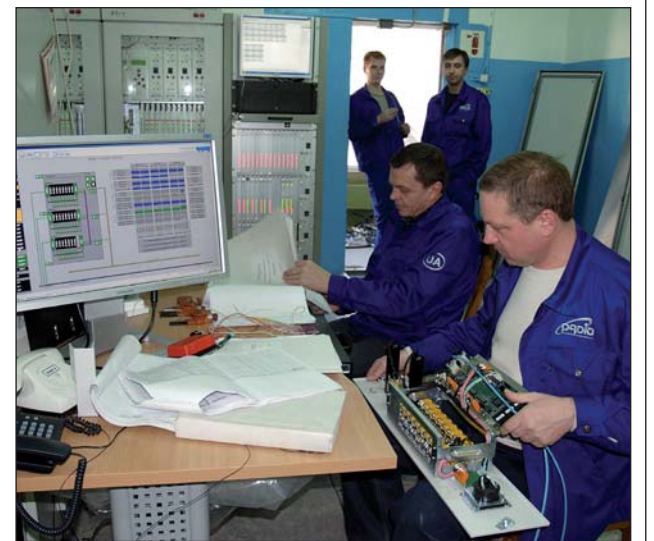
Над новозмонтованими системами чаклюють фахівці «Радію»
