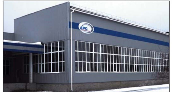
В этом здании расположены ремонтно-механические мастерские, станочный парк, чтобы изготавливать запасные части, детали любой сложности для собственных нужд, восстанавливать оснастку, которую эксплуатирует АРС. Здесь также размещены: стенд для инспекции ядерного топлива компании «Вестингауз» (сам стенд сейчас находится на ЗАЭС, где на пятом блоке уже проведена инспекция, а через полтора-два месяца будет производиться на шестом блоке) и тренажерное оборудование для поддержки квалификации операторов стенда
