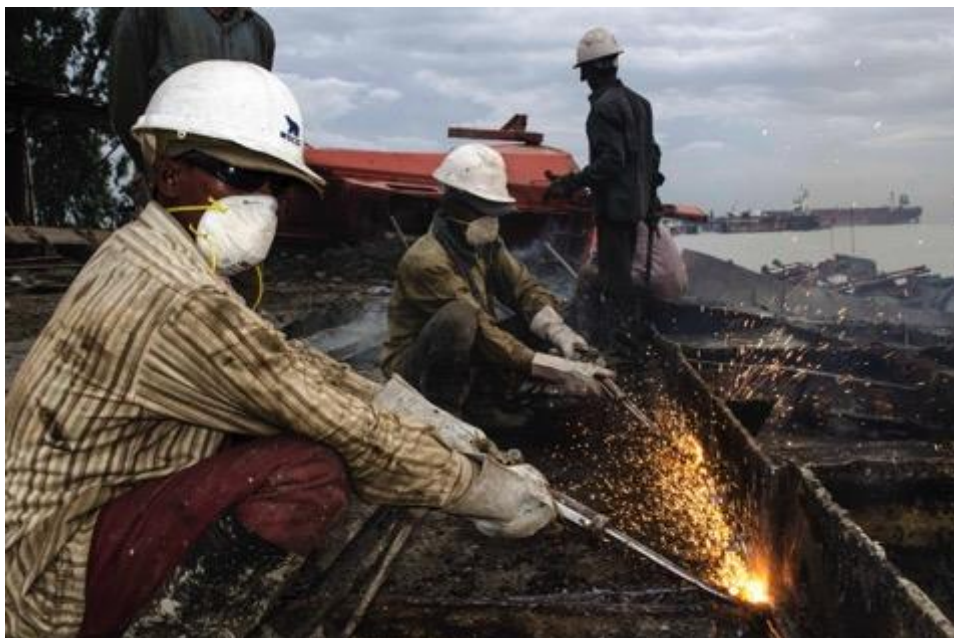
Рабочие верфи по утилизации судов в Читтагонге (Бангладеш). ФОТО: IndustriALL
