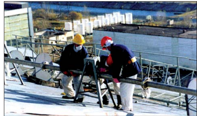
Монтаж нової системи пилоподавлення на об'єкті «Укриття»
