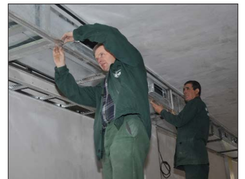
На знімках: стіни ідальні фарбує маляр Тамара ГУЗОВАТА; теслярі Петро ЯЙЧЕНЯ (на передньому плані) та Микола ГУЗОВАТИЙ обладнують каркас вентиляційної системи
