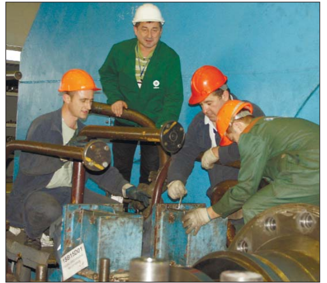
Ремонтні роботи у турбінному цеху енергоблока № 1 Хмельницької АЕС
