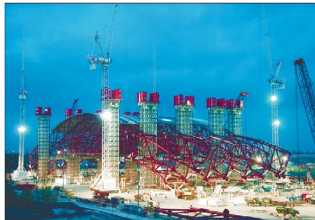
На знімку: майданчик об'єкта «Укриття» Чернобыльської АЕС. 24 листопада тут було виконано перший підйом східної частини арки вагою 5300 тонн на 22 м, що є черговим досягненням у будівництві нового безпечного конфайнмента.
